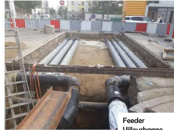
Passage en 6 tubes au-dessus du métro pour compenser la faible profondeur de la galerie.
